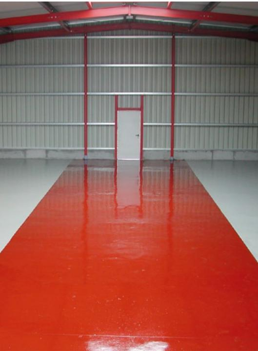
Zur dauerhaften Beschichtung von Bodenflächen haben sich 2-komponentige, wasserdispergierte Reaktionsharze aufgrund ihrer universellen Einsetzbarkeit und sicheren Anwendung in der Praxis vielfach bewährt. Die hahne-Systeme bieten eine einfache und zuverlässige Möglichkeit, Oberflächen zu gestalten und zu schützen.
