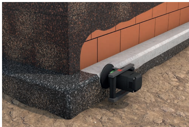
1.2 Boden-Wand-Anschluss von alter Abdichtung befreien (mechanisch)
