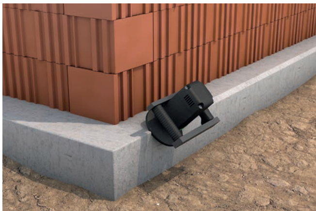
1.1 Senkrechte und waagerechte Kanten anfasen (Beton Schleifer)
